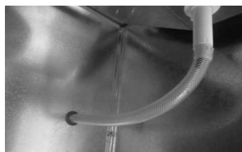
Figura 13: Saída de água do evaporador em processo de degelo
