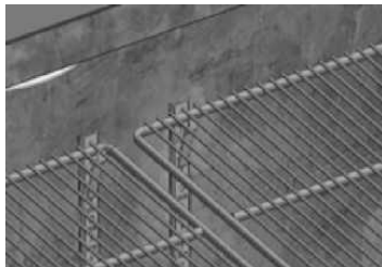
Figura 10: Colocação das grades.
