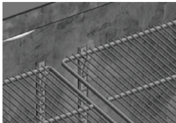
Figura 10: Colocação das grades.
