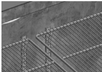
Figura 10: Colocação das grades.
