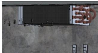
Figura 11: Evaporador Aletado
