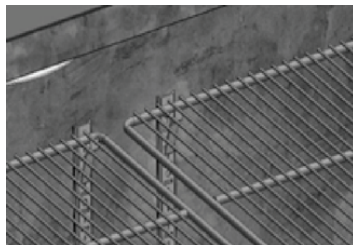
Figura 10: Colocação das grades.
