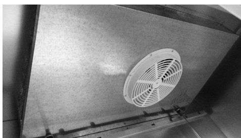
Figura 12: Unidade evaporadora
