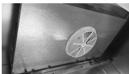
Figura 12: Unidade evaporadora
